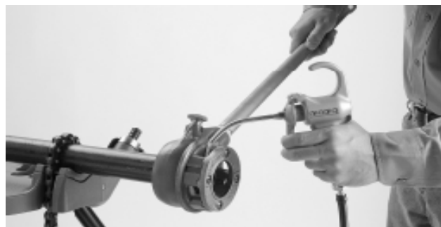
Рис. 4 – Нанесение резьбонарезного масла на трубу
